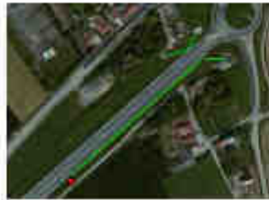
Vue aérienne du mur anti-bruit / situation du point n°2
